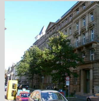
Umbau + energetische Sanierung
